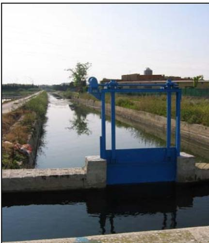
Figura 13: Compuerta que permite aliviar de la acequia Oro (de izquierda a derecha) al azarbe del Ribàs (hacia arriba).
